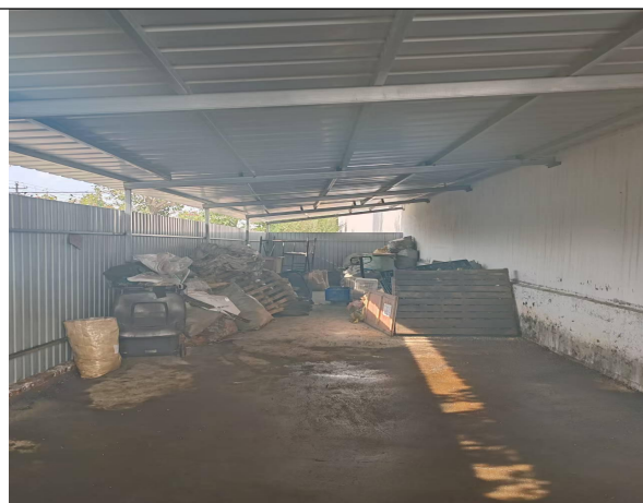
图 5 一般固废暂存间
