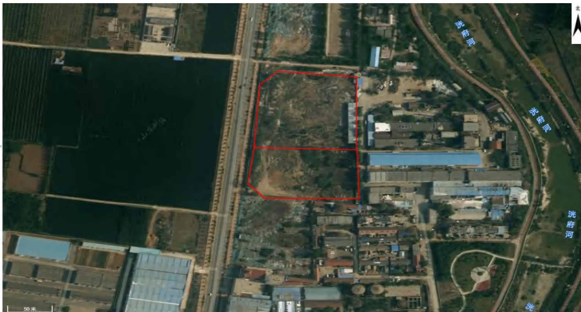
图 3.5-15 2020 年 04 月地块历史影像图（本地块为邢家村集体用地，地块闲置，有少许建筑垃圾，地块内东侧建筑为造纸厂修建的仓库）
